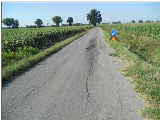
Il terzo intervento prevede il rifacimento completo di porzione di strada esistente, al fine di ricalibrare la sede stradale, rinforzare lo strato di sottofondo e di collegamento e di eliminare la pericolosità intrinseca dello stato attuale.
